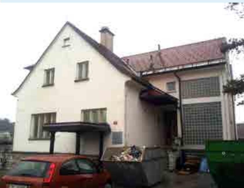
Vila Lučka med obnovo
